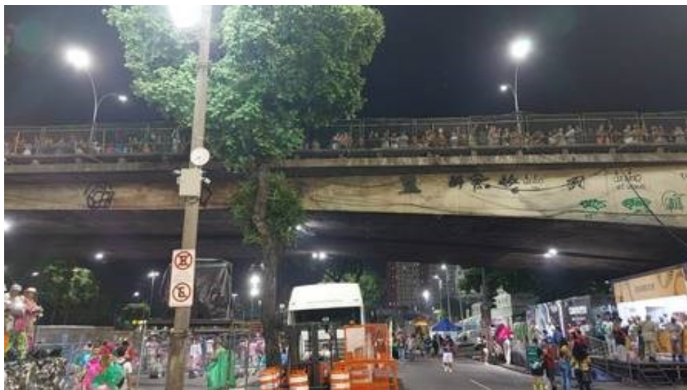
Figura 76 – Público assiste a desfiles das Escolas de Samba do Rio do alto do viaduto
