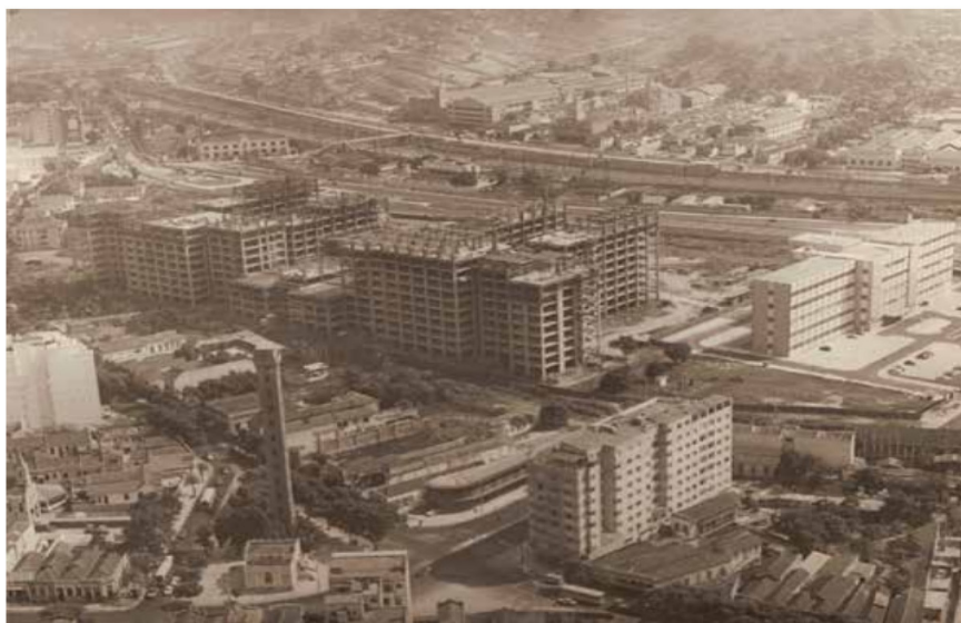
Vista da região do Campus Maracanã durante as obras. Da esquerda para a direita: parte da Capela do Divino Espírito Santo; a Elevatória Sampaio Correa; o Pavilhão Reitor Haroldo Lisboa da Cunha (concluído); o Pavilhão João Lyra Filho, parcialmente erguido. Ao fundo, a via férrea e o Morro da Mangueira, dc. 1970, [s/autor]. Fonte: MID/Rede Sirius.
