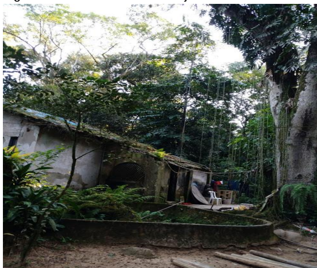
Figura 11: Vista lateral da casa junto à árvore
