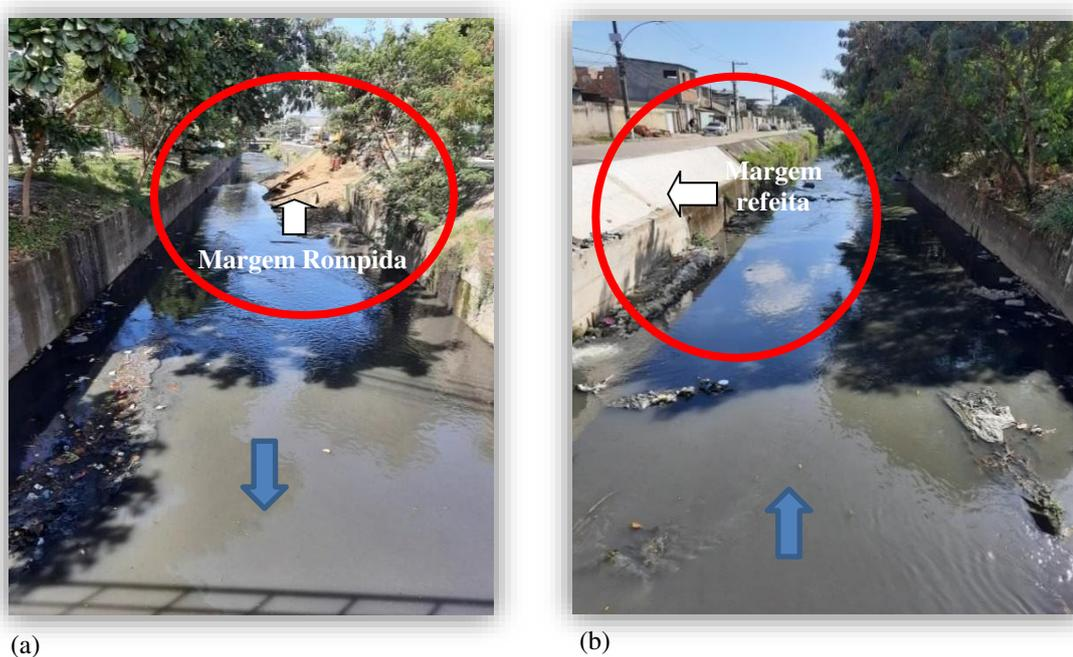
Legenda: Esse ponto corresponde a 23K 7467955.64 metros latitude sul e 644489.66 metros de longitude oeste e 18 metros de altitude sul; (a) - trecho da margem sendo reconstruída pela Prefeitura da Cidade do Rio de Janeiro depois da ruptura da mesma após um evento pluviométrico (a); (b) - trecho da margem que já foi refeita; (a) e (b) - são fotos opostas tiradas da ponte. A seta indica o curso do rio.
