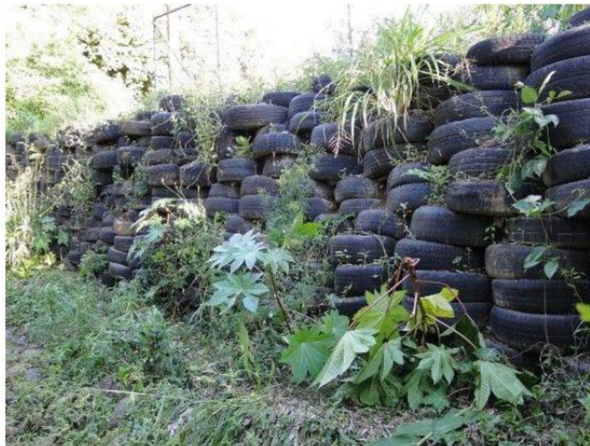
Figura 5 – Muro de contenção feito a partir de pneus inservíveis
