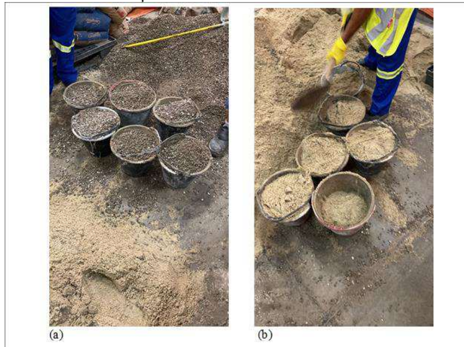
Figura 11 – Agregado graúdo (brita) e agregado miúdo (areia) para fabricação e concreto
