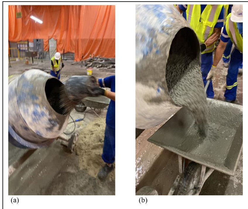
Figura 12 – Fabricação e lançamento do concreto com betoneira
