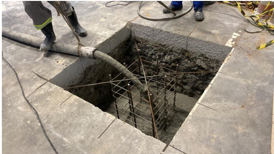
Figura 13 – Lançamento do concreto bombeado
