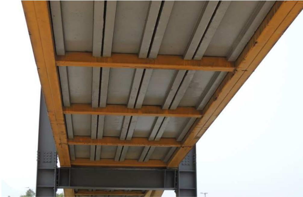
Figura 29: Vista inferior dos elementos da laje pré moldada [64].
