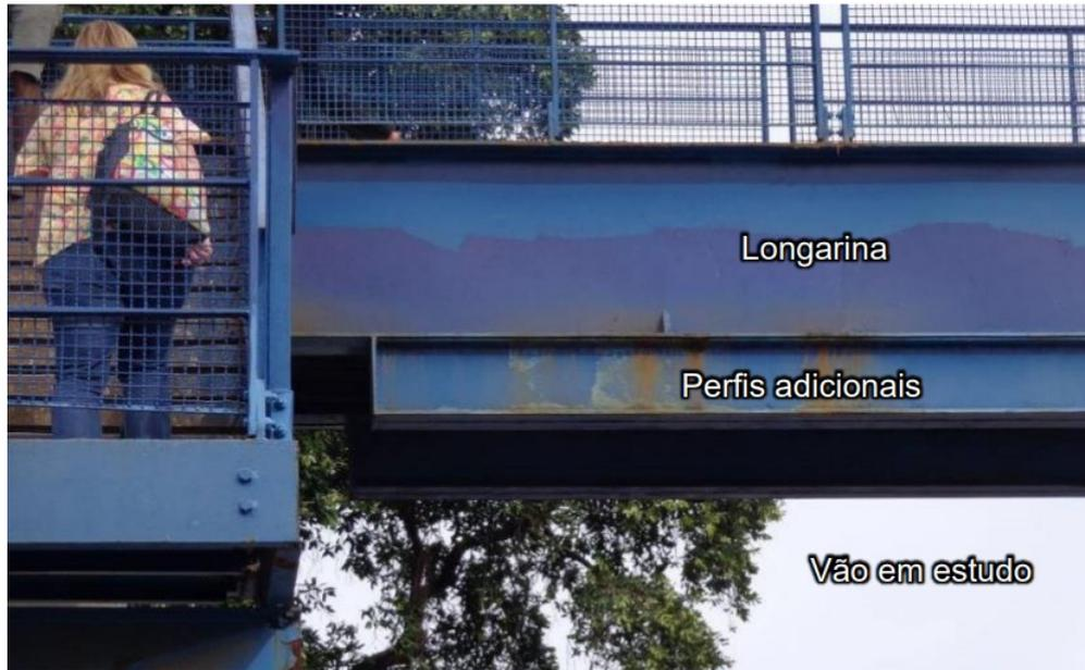
Figura 25 - Vista em detalhes dos perfis adicionais as longarinas [63]
