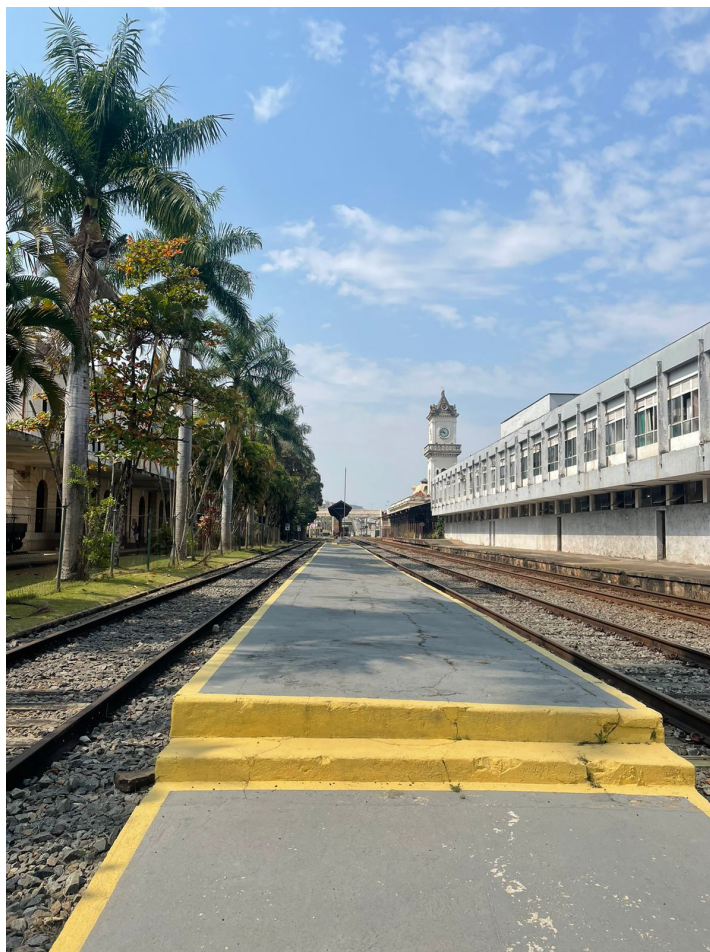
Figura 4 – Vista da Estação Central e do Museu Ferroviário
