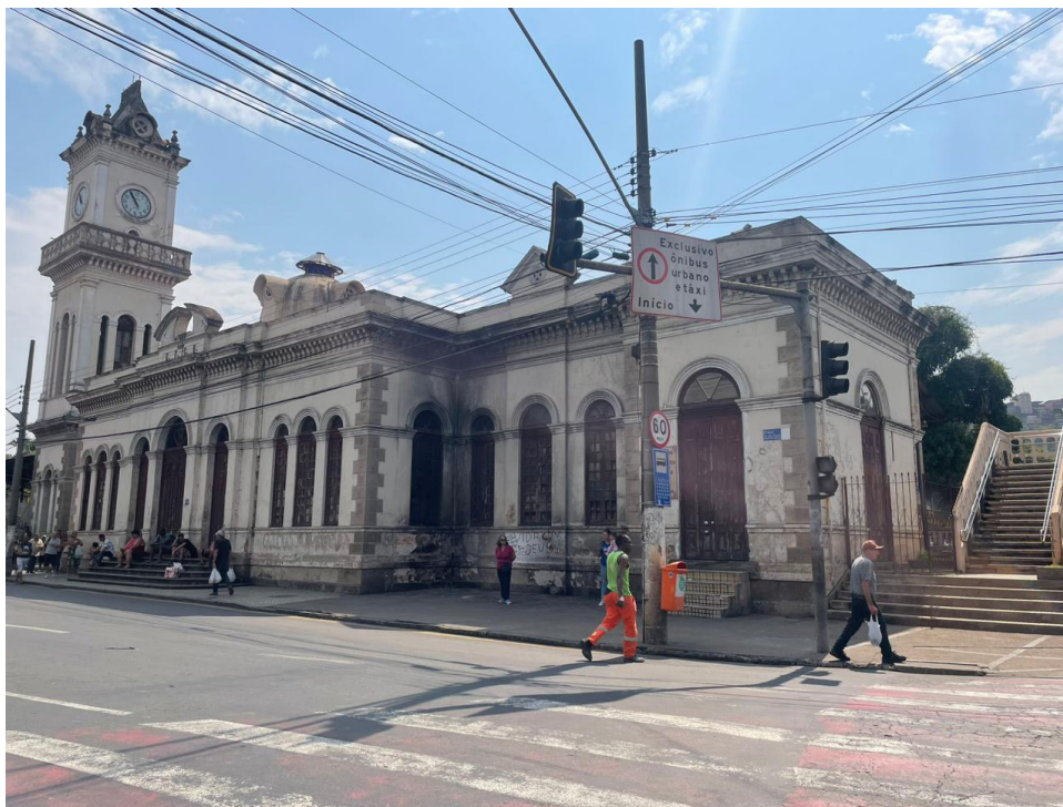
Figura 3 – Estação Central – Juiz de Fora
