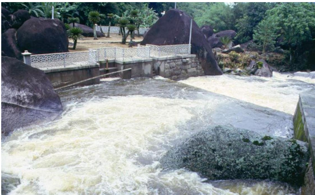
Figura 11 - Unidade de Tratamento de Água São Pedro.
