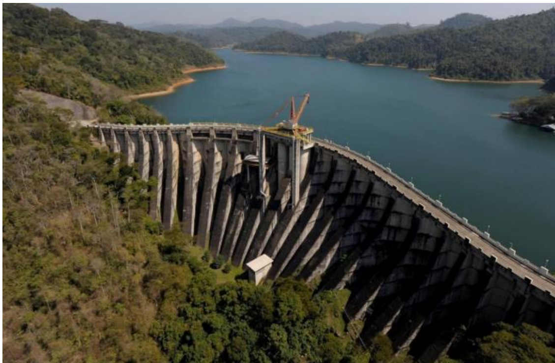
Figura 12 - Represa Ribeirão das Lajes.
