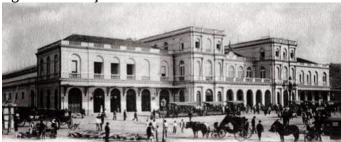
Figura 1 - Estação da Corte – 1870
