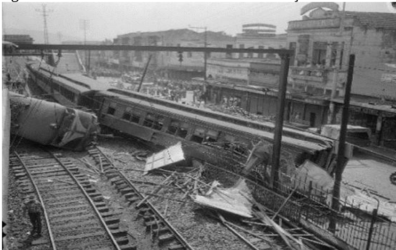
Figura 17 - Acidente com a locomotiva na estação de Madureira
