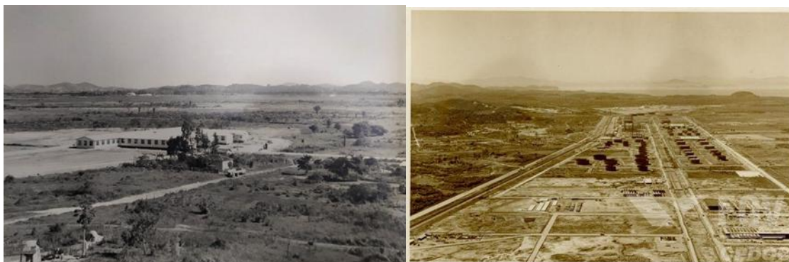
Figura 8- Construção da REDUC
