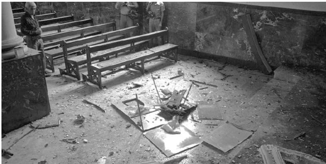
Figura 37 – Interior da catedral da Igreja Santo Antônio da Jacutinga. Bomba destrói altar do Santíssimo Sacramento
