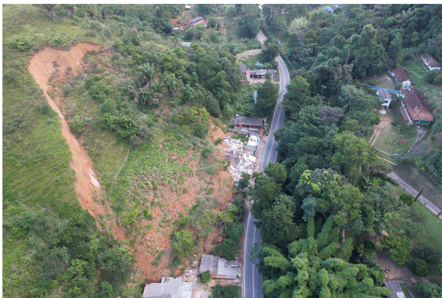
Figura 19 – Deslizamento Rotacional em Mendes – RJ.
