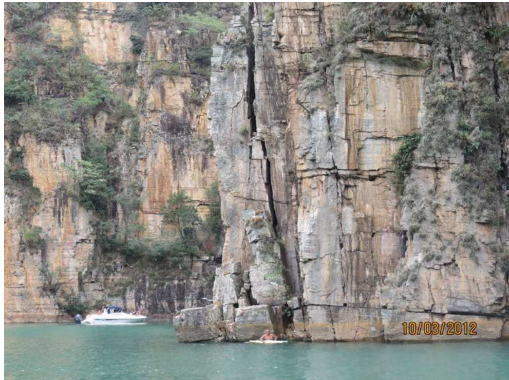
Figura 25 - Paredão em Capitólio com a trinca que levou ao tombamento.
