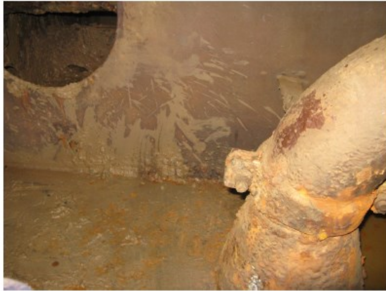
Figura 7 – Região de enchimento/esvaziamento de tanques ( bellmouth ) [8]
