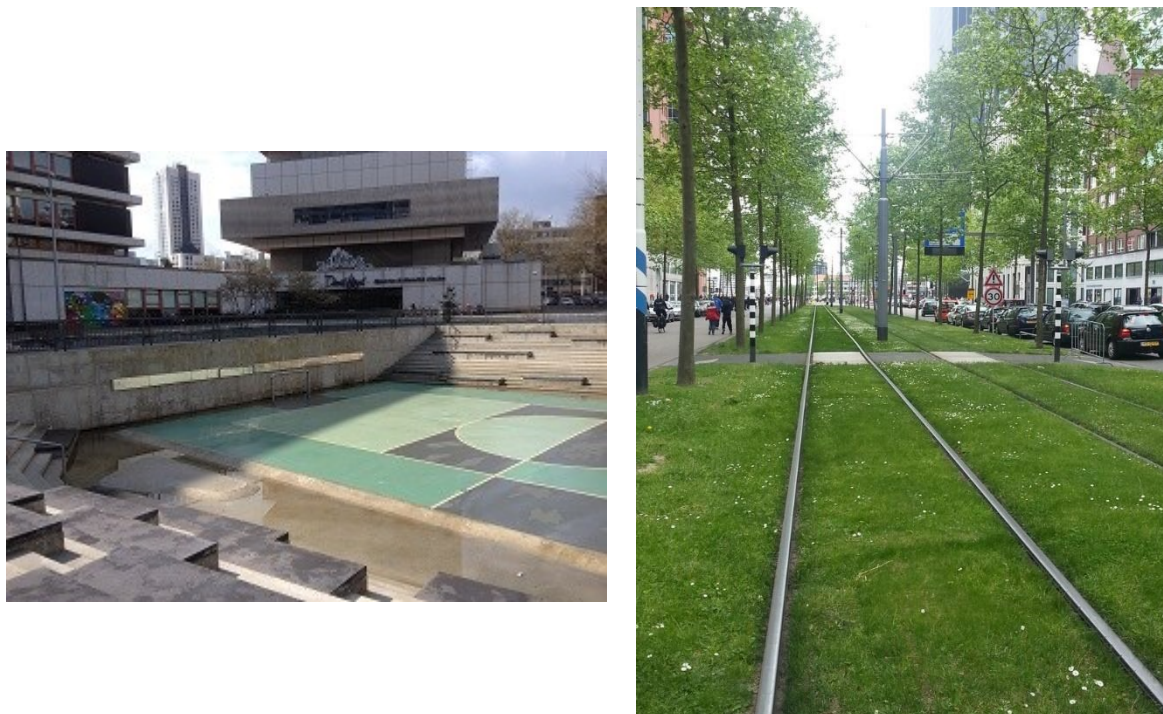
Figura 3 - Soluções adotadas na cidade de Roterdã, Holanda. a – área de reservação de água da chuva. b – área de passagem de bonde com pavimento permeável.
