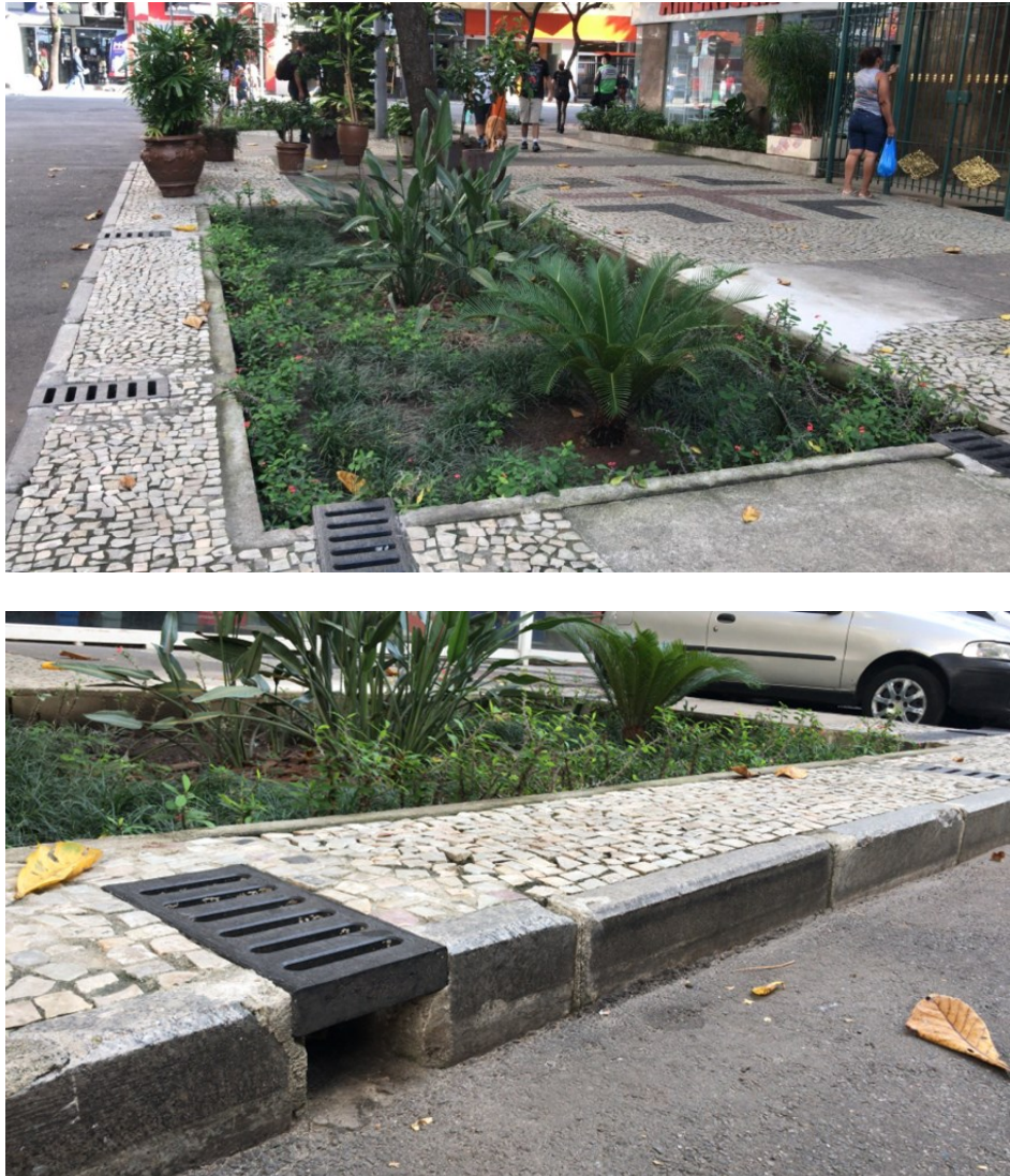
Figura 66 - Detalhe da ligação da rua com o jardim de chuva instalado no bairro de Copacabana, Rio de Janeiro, Brasil.
