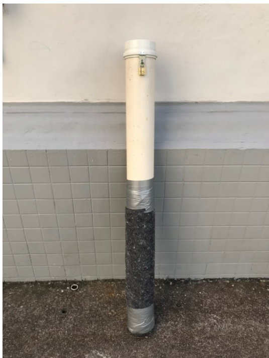
Figura 25 - Tubo instalado no centro do jardim com perfurações laterais e fundo aberto, envolto em manta geotêxtil.
