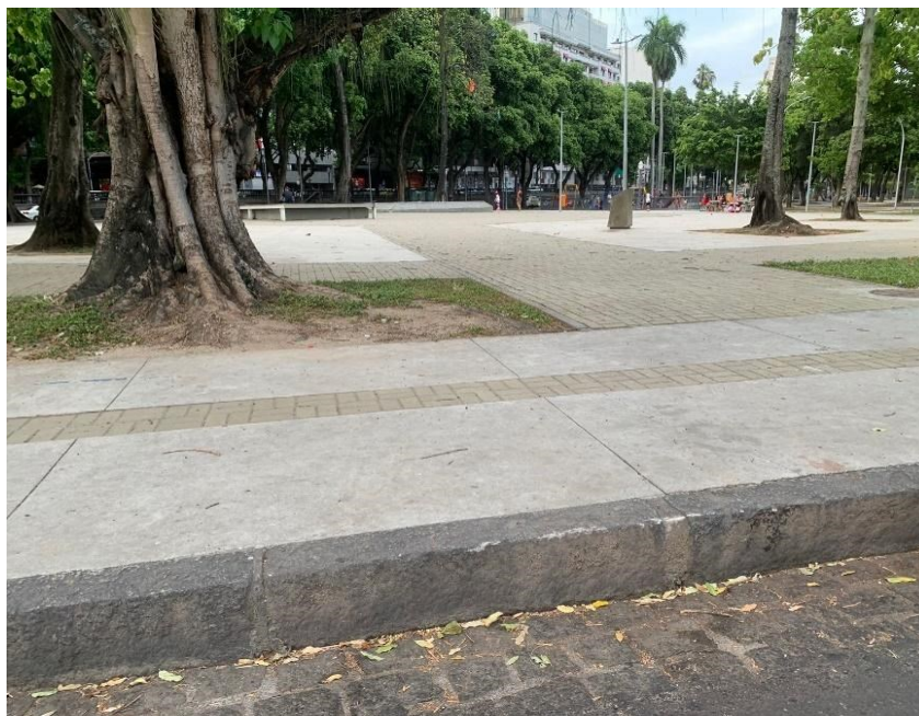
Figura 67 - Piso de cimento utilizado nas praças do bairro da Glória, cidade do Rio de Janeiro, em reforma realizada ao longo de 2023.
