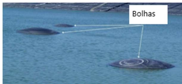
Figura 1. Imagem de uma Lagoa de geomembrana com formação de bolhas (*whales*), acima do nível do líquido (adaptado de Marta, 2022).
