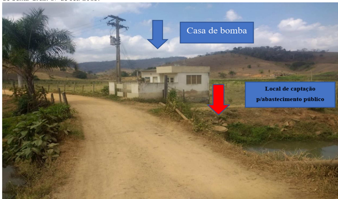
Foto 01 - Benfeitorias destinadas a captação de água para abastecimento público – Ribeirão Bom Jardim, distrito de Santa Cruz. 17 de set. 2019.
