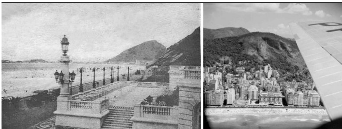
Figura 19 – Avenida Atlântica após a construção.
