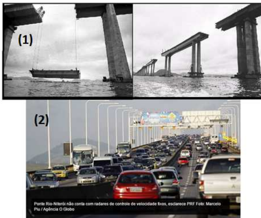
Figura 48 – (1) Construção da Ponte Rio-Niterói e (2) Trânsito Intenso na Ponte.
