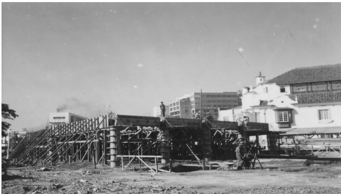
Figura 43 – Avenida Perimetral – Início da Obra. Autor: BERNARDES, Nilo. 1922-1991. (Título: Obras da Avenida Perimetral em frente à Estação de Hidros da Panair.)
