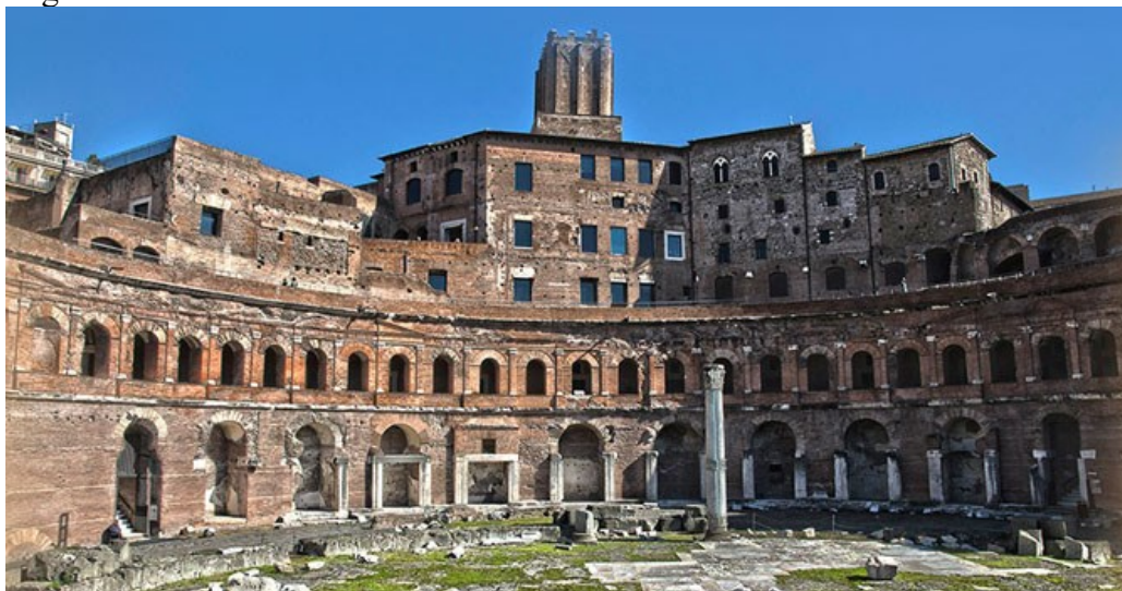
Figura 2 – Vista externa do Mercati di Traiano
