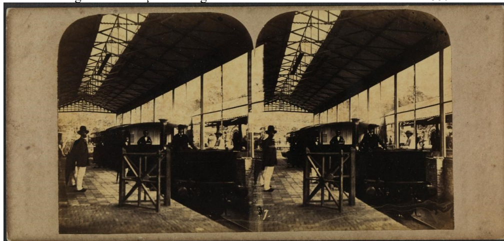
Figura 2 – Estação de Fragoso – Estrada de Ferro Barão de Mauá - 1860
