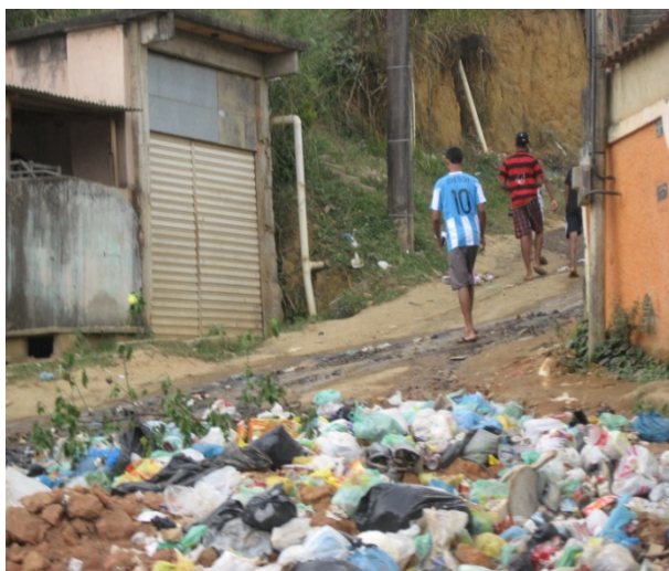
Foto 17 – Problemas estruturais: Falta de coleta de lixo
