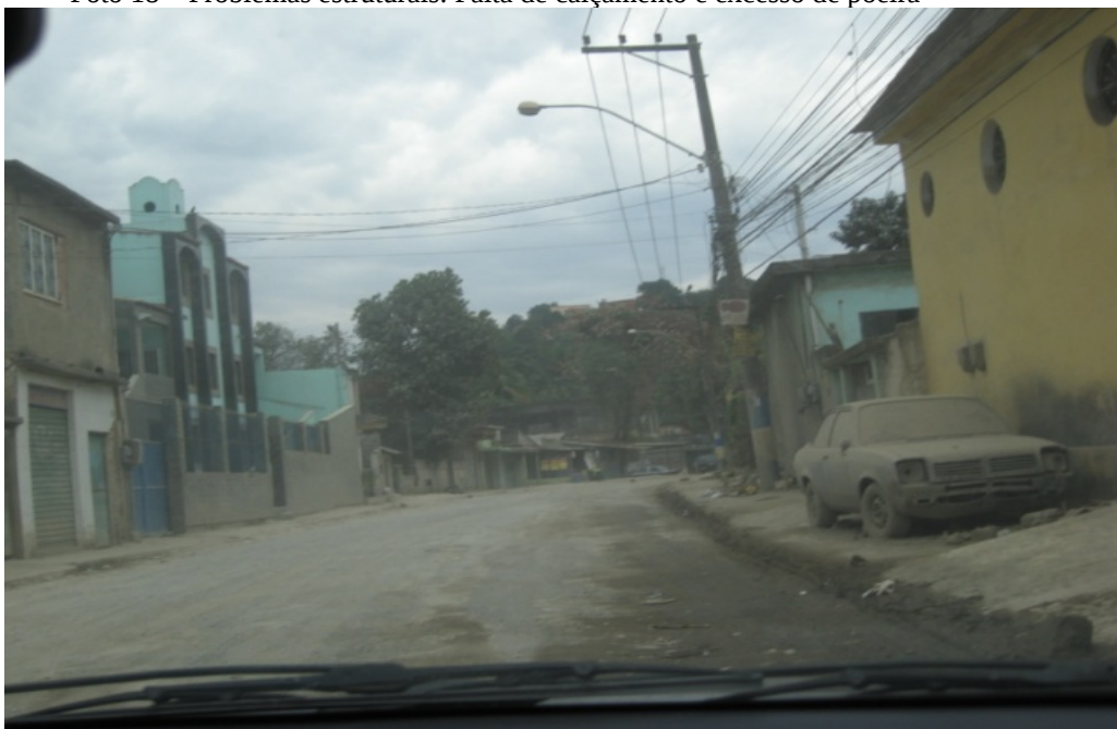
Foto 18 – Problemas estruturais: Falta de calçamento e excesso de poeira
