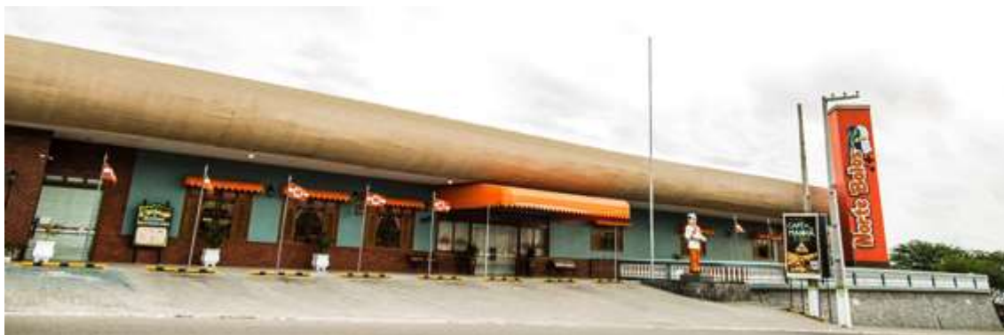
Figura 52 – Fachada da Norte Bolos
