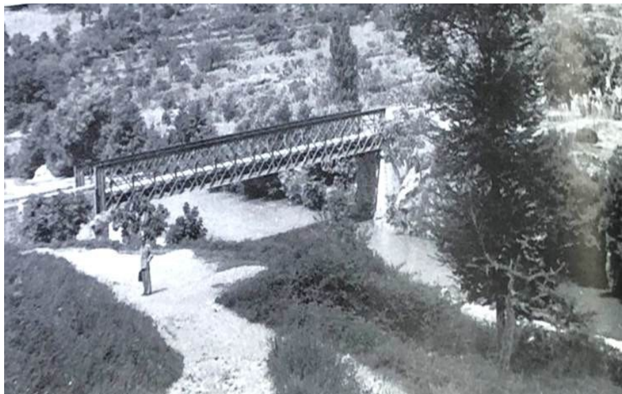
Figura 1 - Ponte de ferro sobre o rio Laos.
