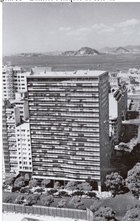
Imagem 33 - Edifício Marquês do Herval
