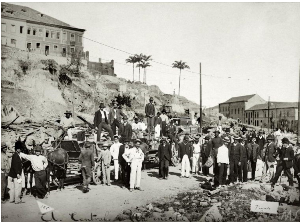
Imagem 3- Desmonte de parte do Morro do Castelo para a construção da Avenida Central
