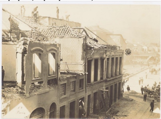
Imagem 15 - Avenida Central - obras de demolição e de preparação para pavimentação
