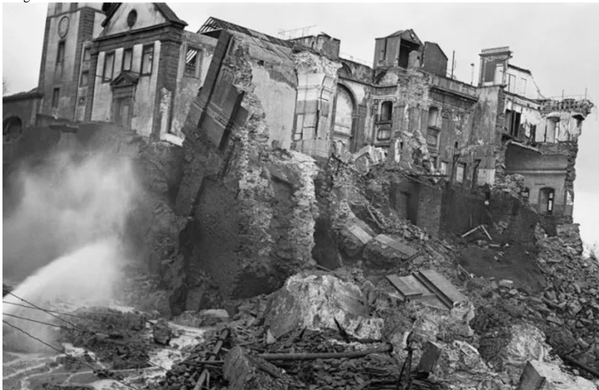
Imagem 19 - Desmonte do Morro do Castelo
