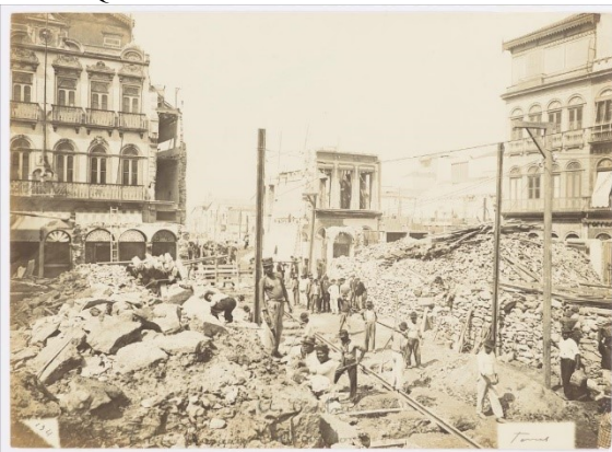
Imagem 14 - Avenida Central - demolições entre as ruas da Quitanda e do Ouvidor
