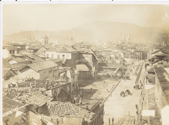
Imagem 16 - Avenida Central - obras de preparação para pavimentação; trecho em direção à Prainha
