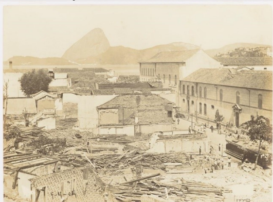
Imagem 17 - Demolições em frente ao antigo convento da Ajuda
