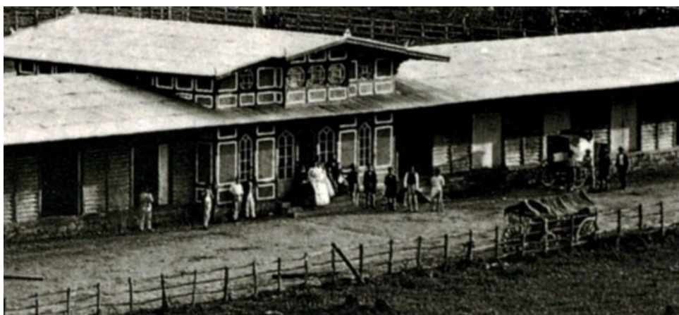
Fotografia onde se vê a parte central – com hotel e restaurante – da Estação Rodoviária de Entre-Rios.
