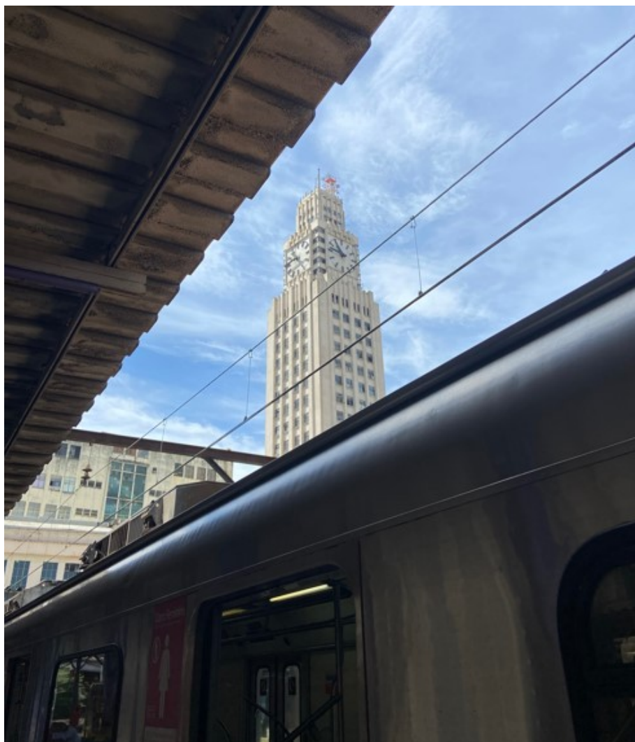
Figura 33 – Vista parcial do prédio Central do Brasil
