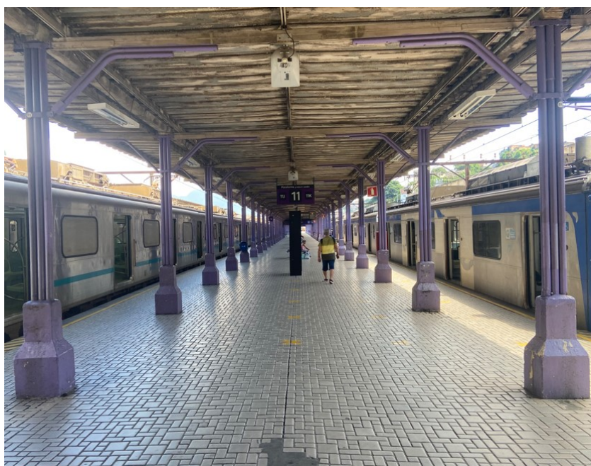
Figura 31 - Plataforma 11 ramal Belford Roxo
