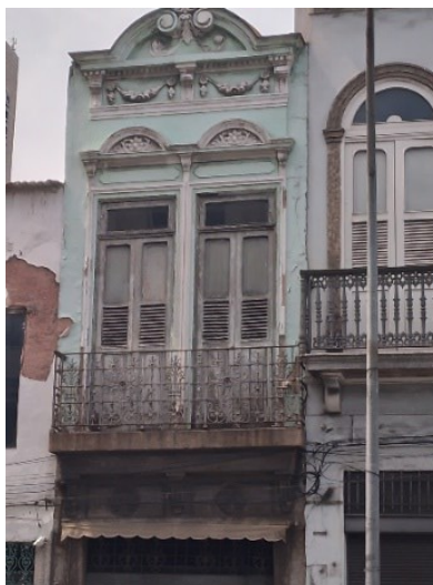
Figura 38 – Prédio na Rua Visconde do Rio Branco, 27
