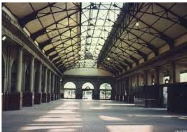
Figura 19 - Plataforma de embarque da Estação Visconde de Mauá
