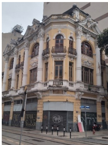
Figura 37 – Prédio na Rua Sete de Setembro, 237
