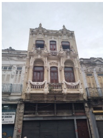
Figura 36 – Prédio na Rua Sete de Setembro, 196
