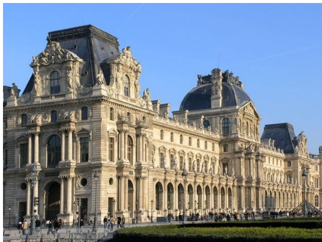
Figura 7 - Fachada do Museu do Louvre
