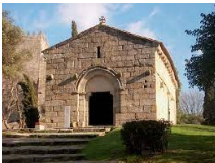
Figura 31 - Capela de São Miguel do Castelo
