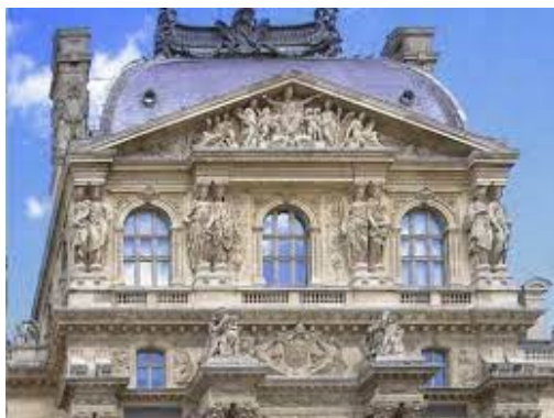
Figura 82 - Partes da fachada do Museu do Louvre
