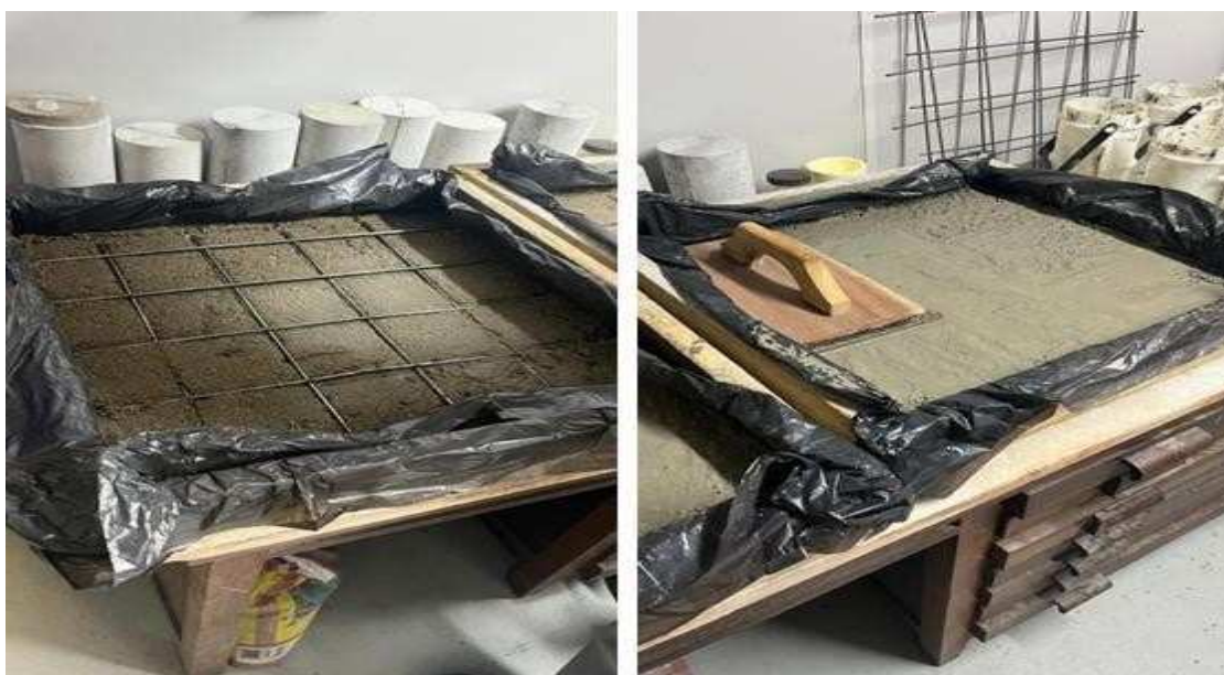
Figura 13 – Concretagem das formas
