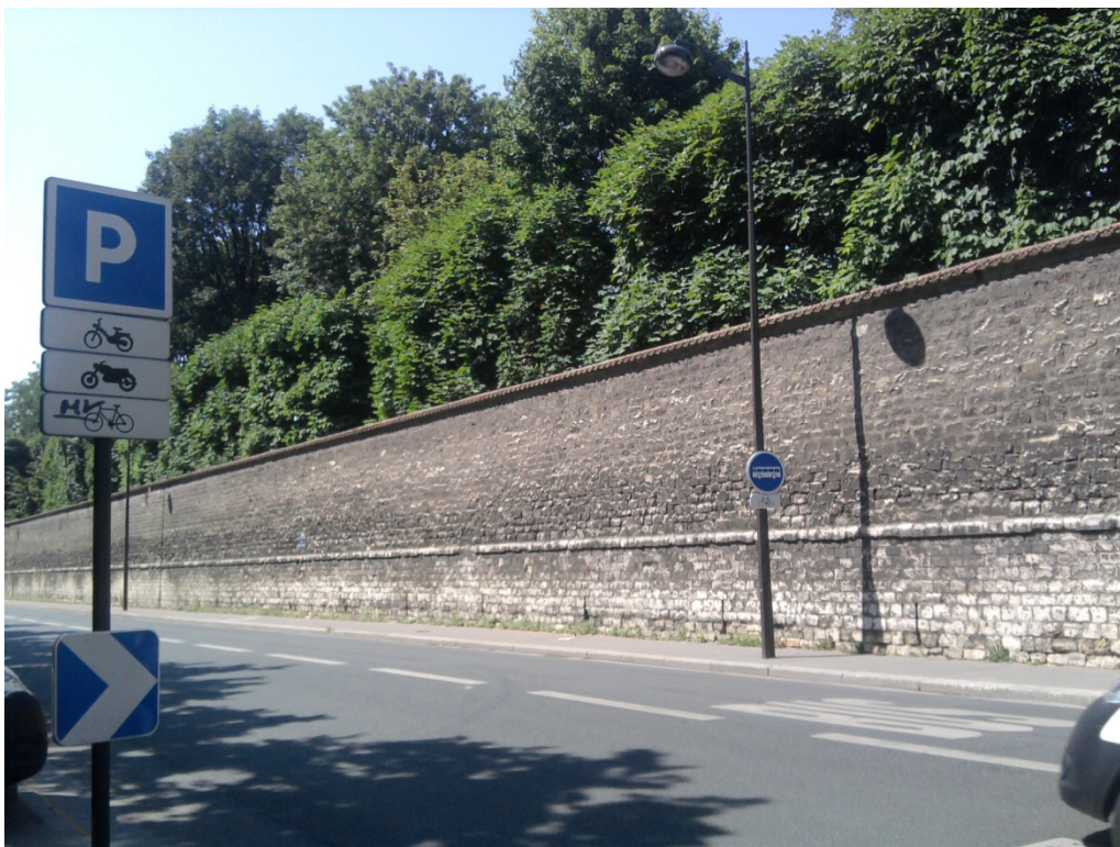
Figura 1: Fotografia do grande muro que separa o Centre Hospitalier Sainte Anne da rue de la Santé , em Paris.
