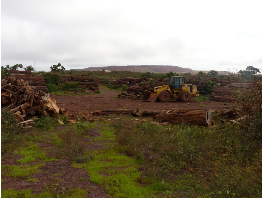
Figura 10 - Aproximação do pátio de madeira no ponto 6 da trilha A na área de Canga Impactada em Serra Norte da Floresta Nacional de Carajás.
