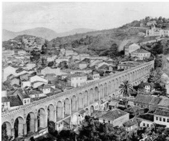
Figura 81 - Fotografia do aqueduto
