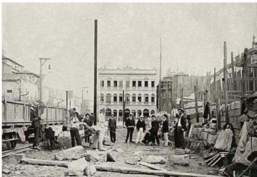
Demolições para a construção da avenida Central, 1904-1905 João Martins Torres – Acervo Instituto Moreira Salles
