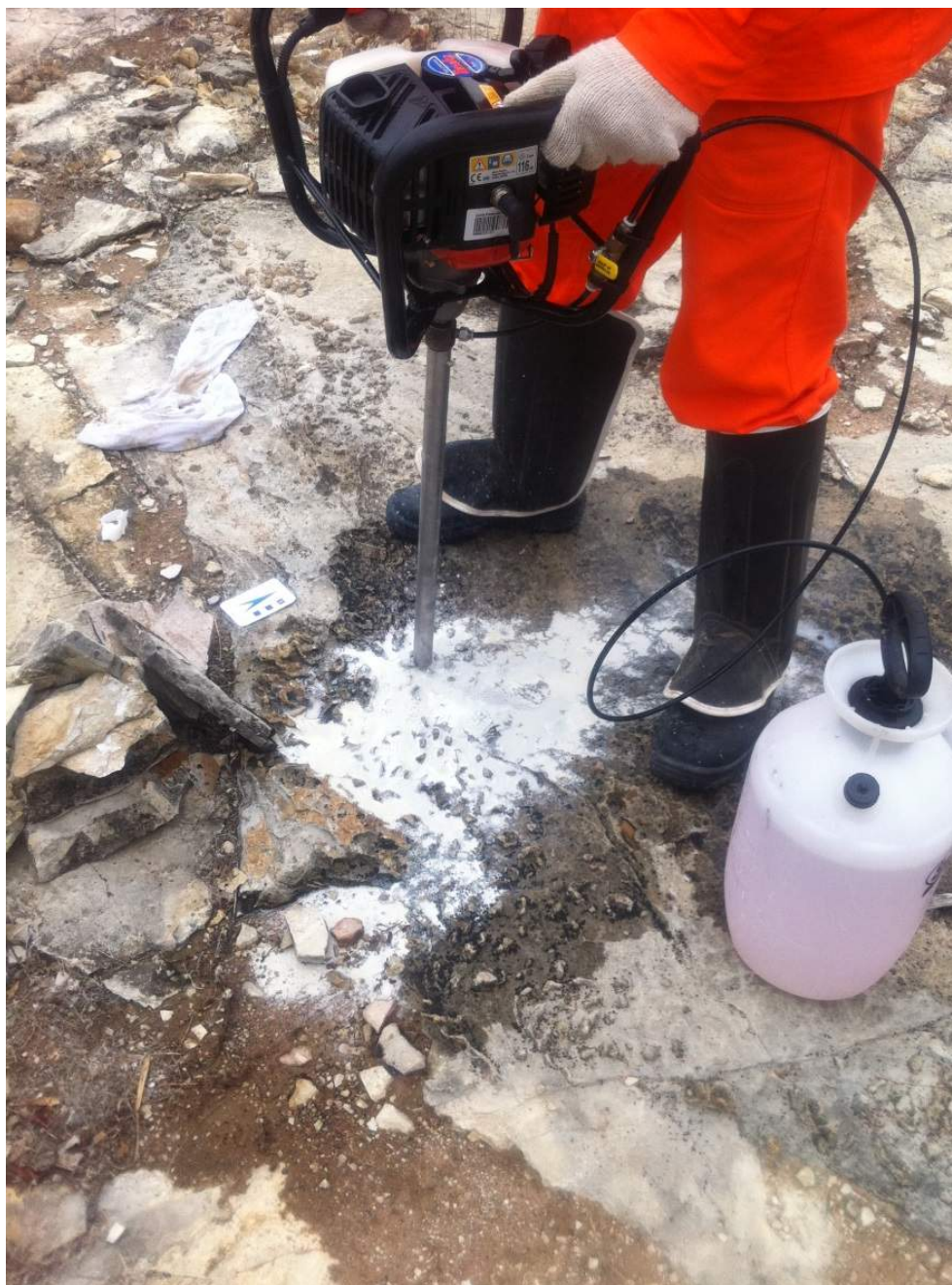
Figura 26 - Local da sondagem FAR7
