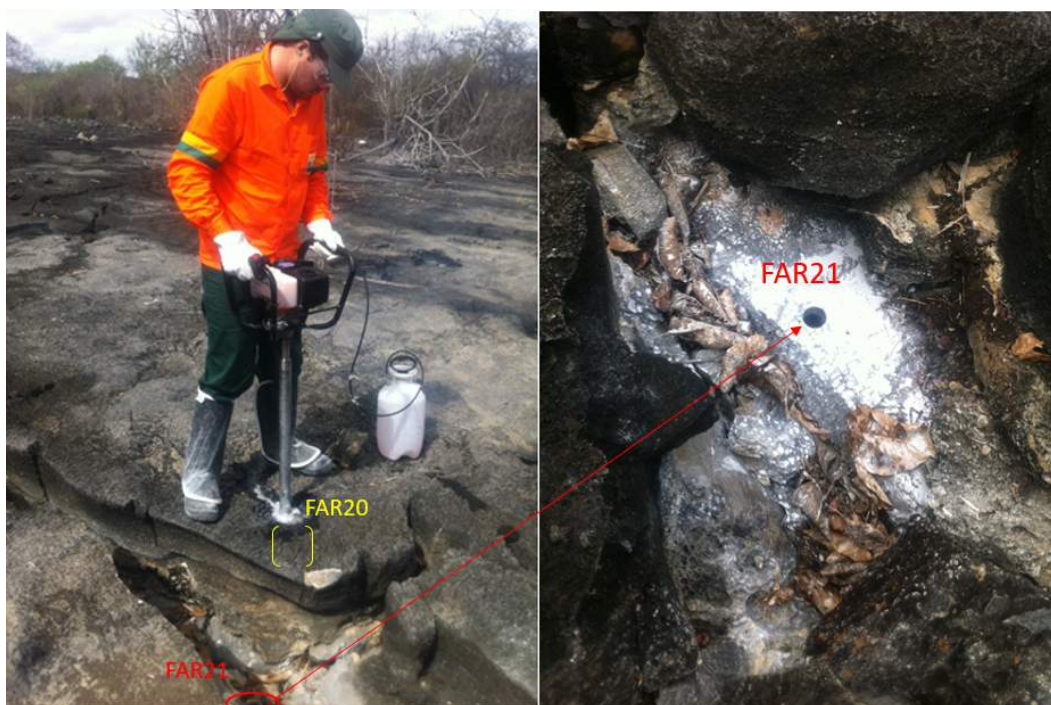
Figura 30 - Local da sondagem FAR21
