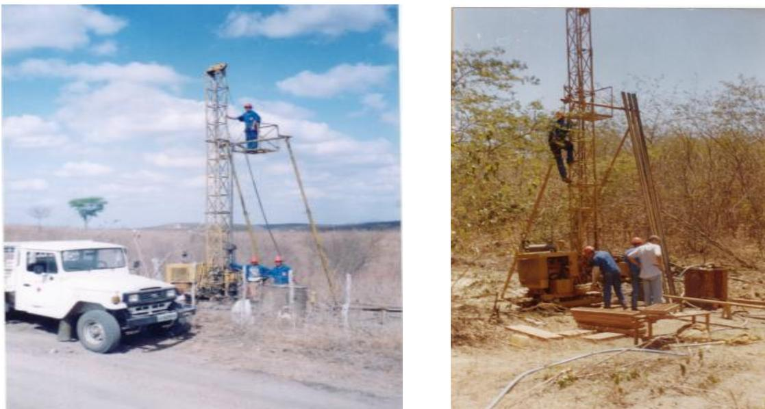
Figuras 45 e 46 - Sondagem rotativa do alvo Erom, com o método *wire line*
