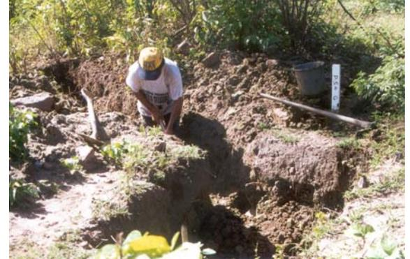
Figuras 39 e 40 - Abertura mecanizada (2 a 3m de profundidade) e manual de trincheiras, no Alvo Cava Sul
