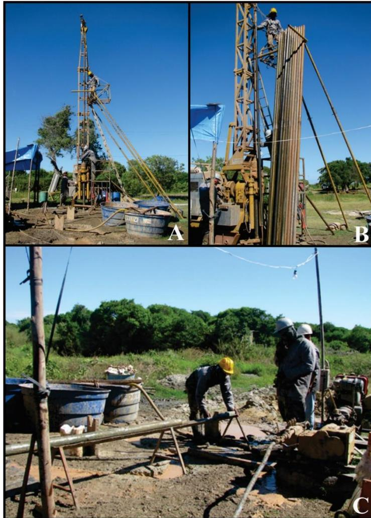
Legenda: A e B - Estrutura da sonda MACH 1200; C - Seções sedimentares recém-recolhidas na sondagem.
