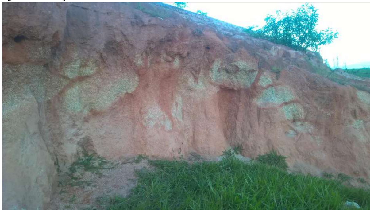
Figura 26 - Esfoliação esferoidal em blocos semi-enterrados
