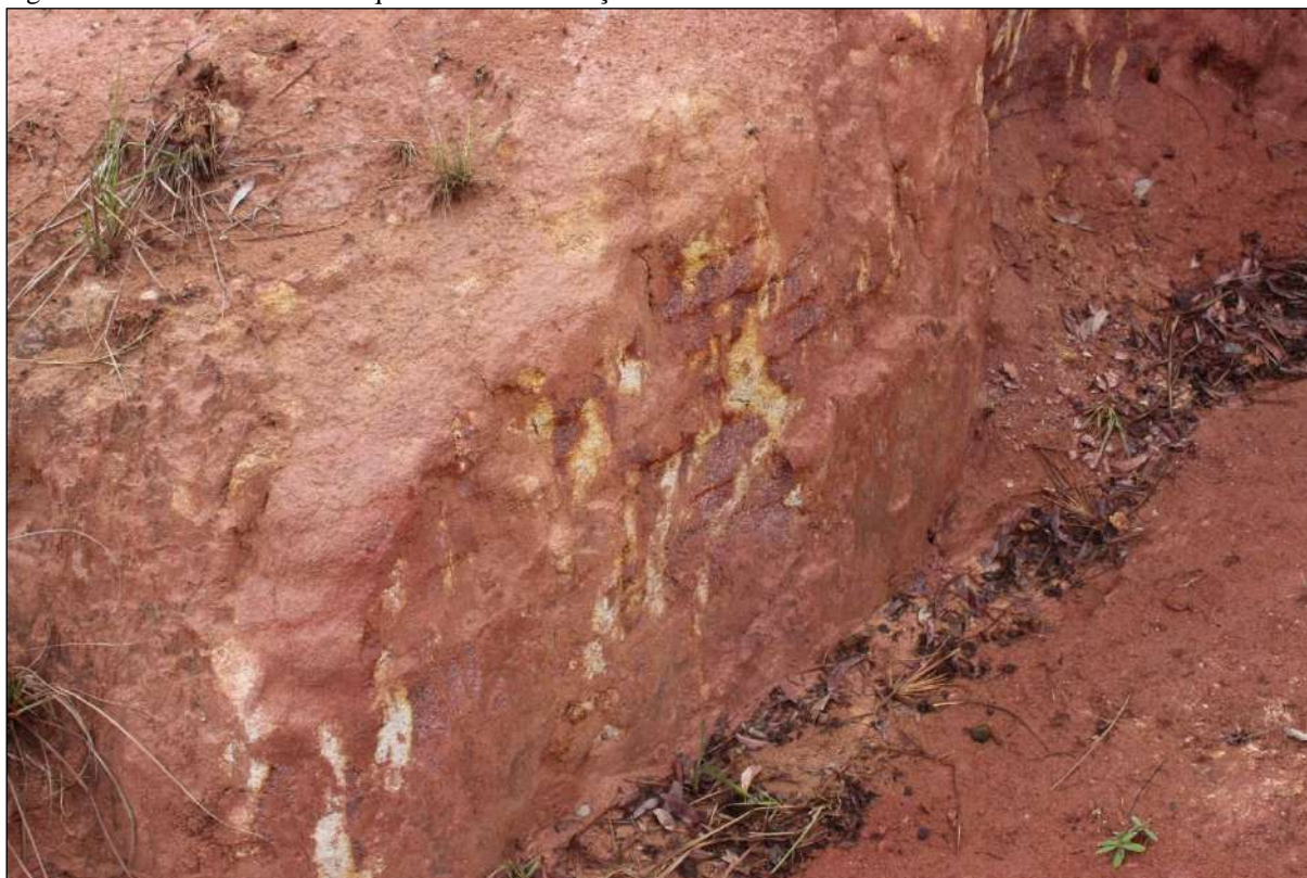
Figura 61 - Sistema de fraturas que afetam a Formação Barreiras
