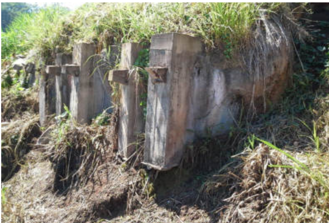
Figura 49 - Obras de contenção – Vistoria local.
