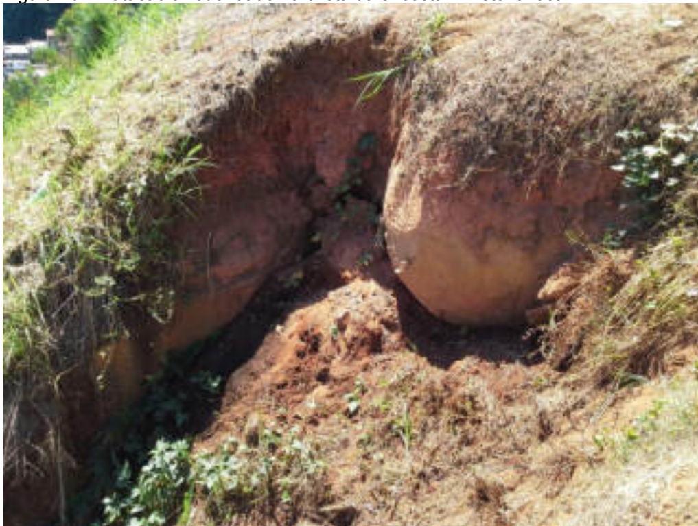
Figura 46 - Matação arredondado na crista da encosta – Vistoria local.
