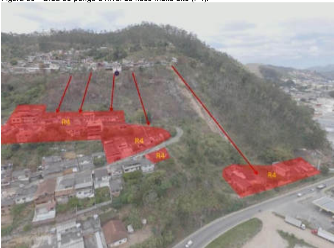
Figura 50 - Grau de perigo e nível de risco muito alto (P4).
