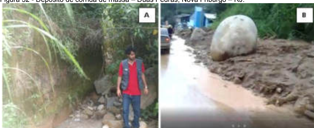
Figura 32 - Depósito de corrida de massa – Duas Pedras, Nova Friburgo – RJ.
