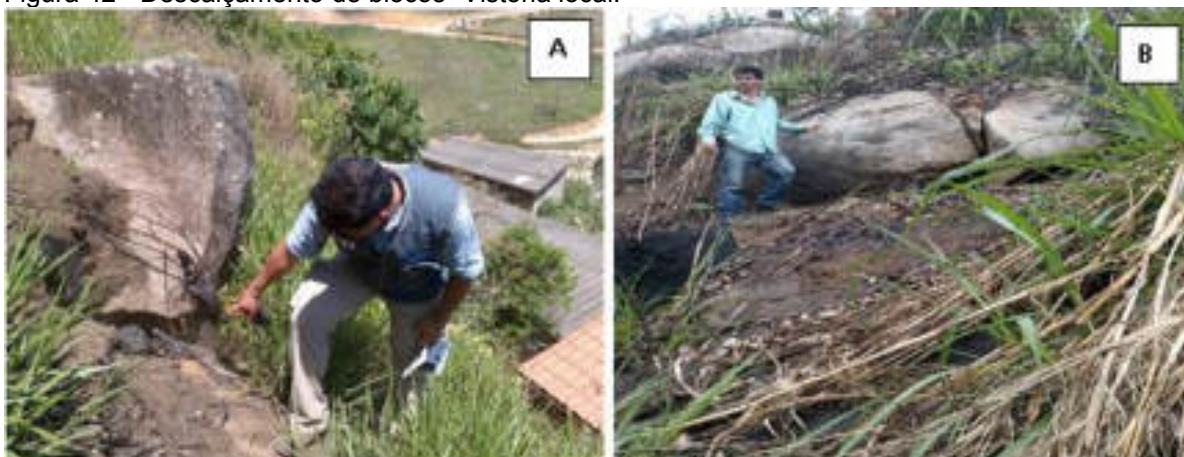
Figura 42 - Descalçamento de blocos -Vistoria local.
