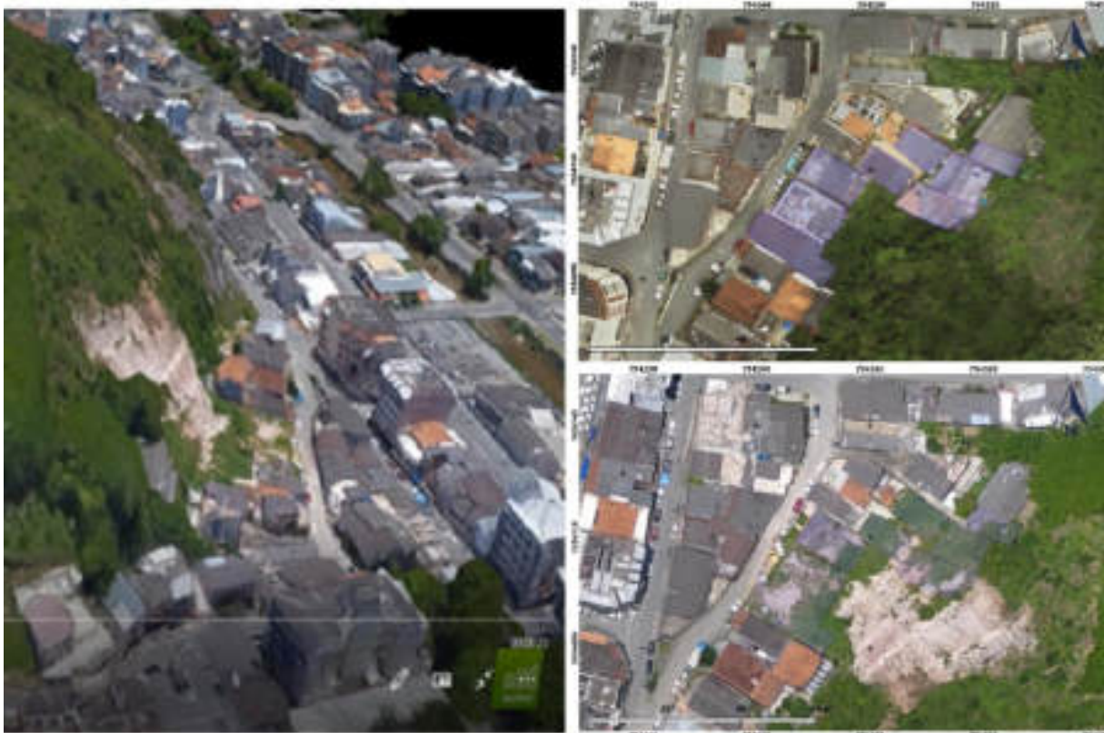
Figura 22 - Verificação 3D no bairro Vilage para deslizamento planar.
