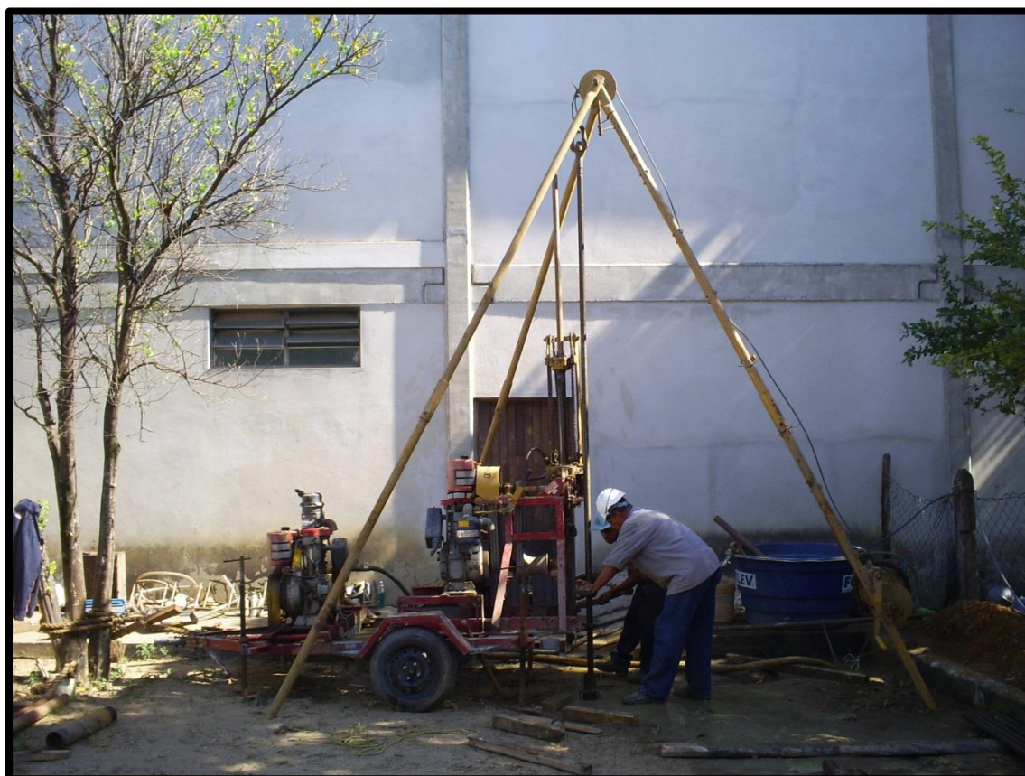
Figura 12 - Sonda Rotativa Mach 920 na perfuração do poço MOR-1-SP. Fonte: BERGAMASCHI, 2012
