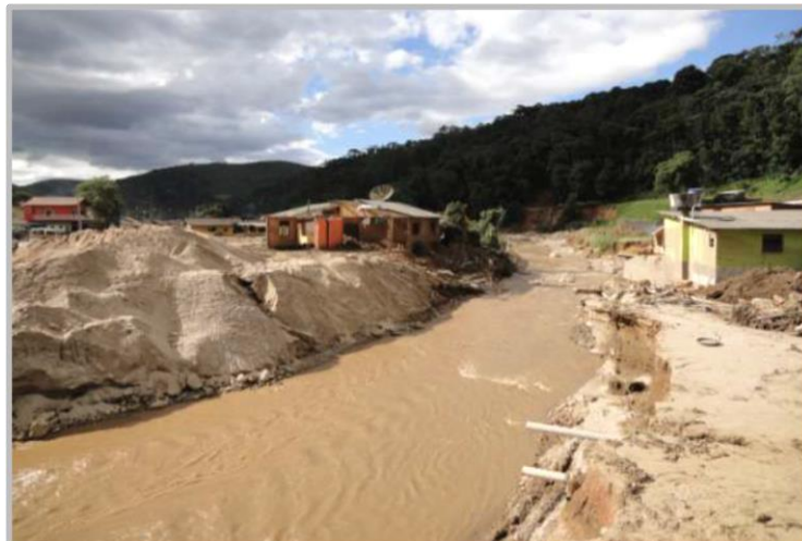
Figura 19 - Área afetada pela corrida de lama e inundação com destruição de residências localizadas na margem do rio, no Vieira, em Teresópolis.
