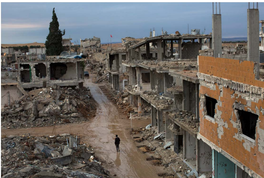
Figura 34: Destruição em Kobani, Síria, 2015- Foto Tyler Hicks / The New York Times
