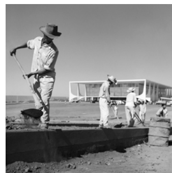
Fig. 19. Trabalhadores nas obras de Brasília, 1958. Foto: Peter Scheier/Acervo IMS.
