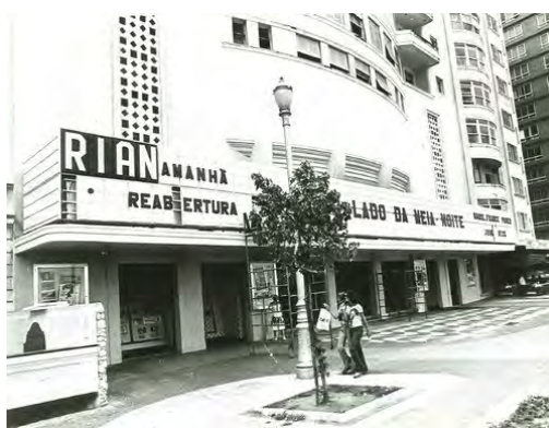
Fig. 22. Fachada do Cine Rian na Av. Atlântica. A PG funcionou em uma das lojas de rua do cinema.
