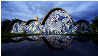
Fig. 12. Igreja da Pampulha (Belo Horizonte, MG) inaugurada em 1943, projeto Oscar Niemeyer e painel de Cândido Portinari.
