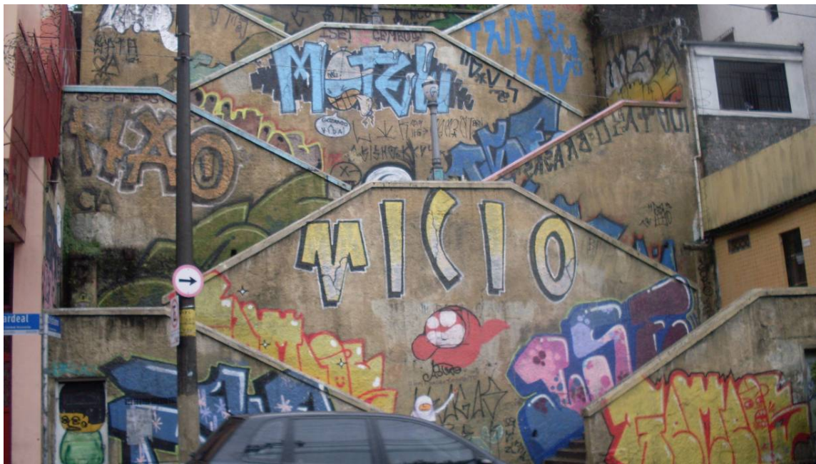
Figura 21: Escada na Rua Cardeal Arcoverde, São Paulo, SP.(Acervo pessoal, foto tirada pela autora, out 2009)
