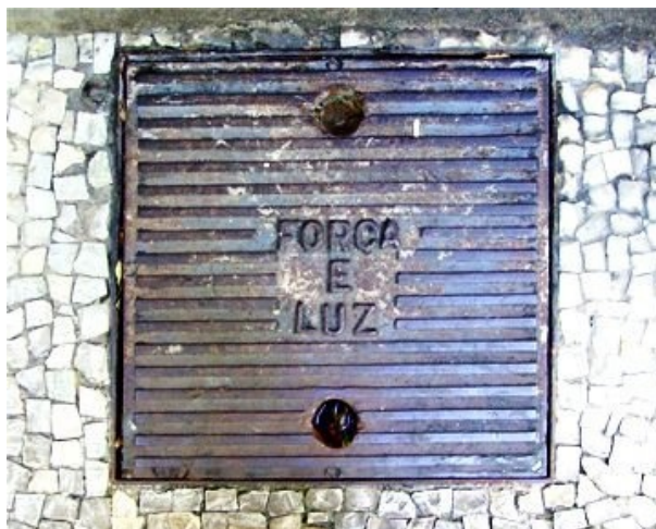
Figura 5 – Foto de tampa de bueiro Força e Luz #1 148
