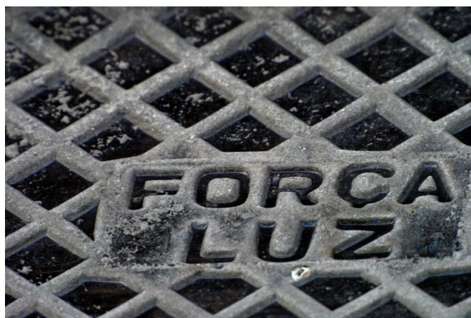
Figura 6 – Foto de tampa de bueiro Força e Luz #2 149
