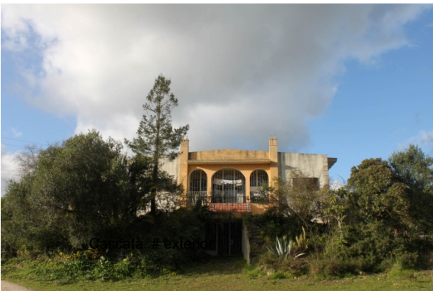
Casa Albergue de residências # exterior
