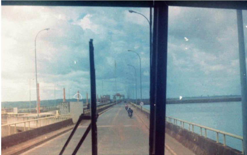
Imagem 15 – Barramento do rio Tocantis – UHE Tucuruí
