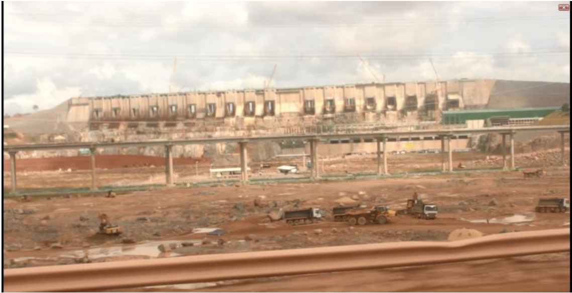
Imagem 16 – Reservatório intermediário em construção/ UHE Belo Monte
