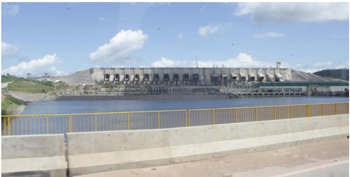
Imagem 17 – Reservatório intermediário ainda não ativado/ UHE Belo Monte
