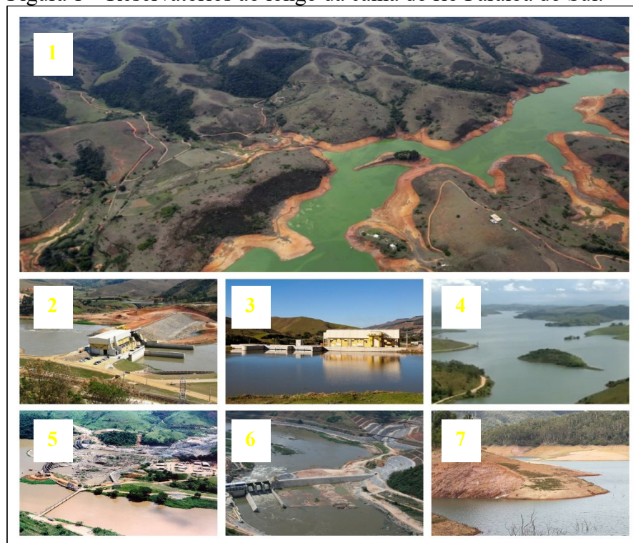
Figura 1 – Reservatórios ao longo da calha do rio Paraíba do Sul.
