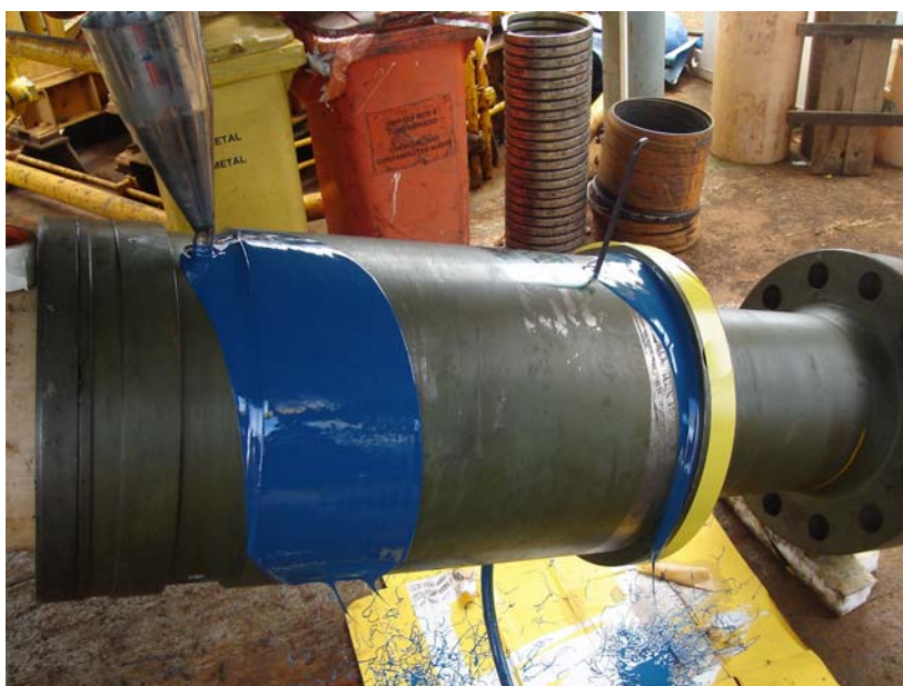
Figura 3.3: Injeção de resina epóxi no conector de extremidade (Petrobras)
