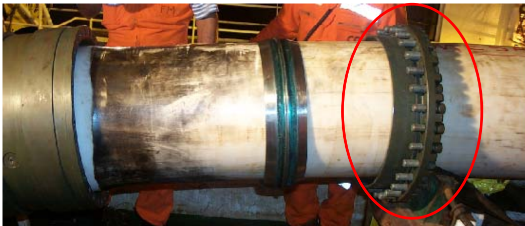
Figura 3.2: Fechamento do flange traseiro (Petrobras)
