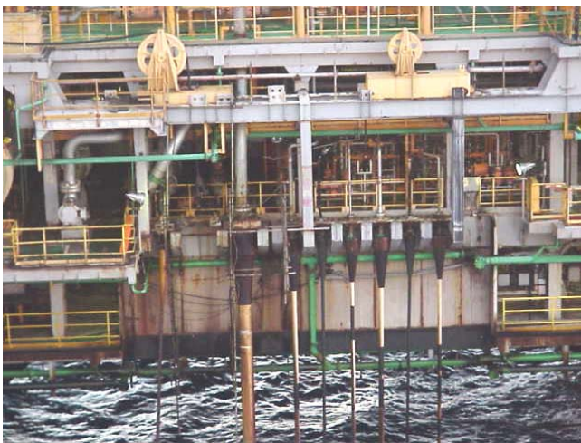
Figura 2.13: Suporte de conectores emerso (Petrobras)
