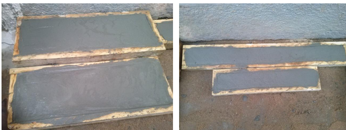
Figura 19 - Concretagem das amostras
