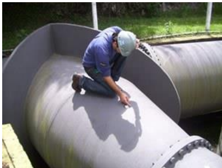
Figura 1 - Inspeção por ensaio visual
