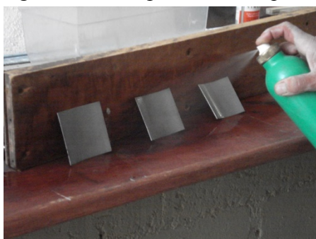
Figura 49 – Limpeza da área que serão coladas
