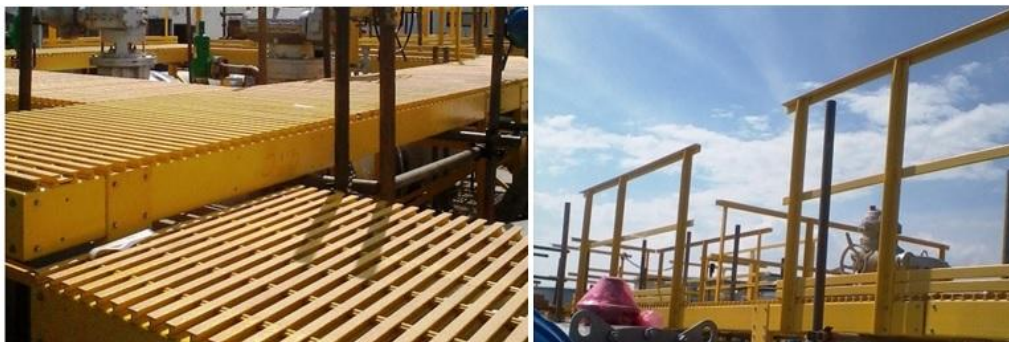
Figura 1 - Piso e passarela fabricados em material pultrudado
