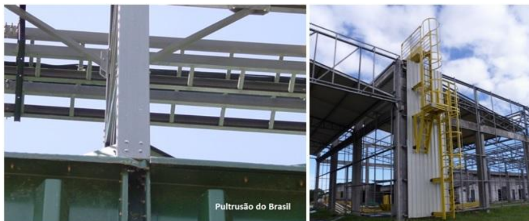
Figura 2 – Leito pultrudado para cabos e escadas
